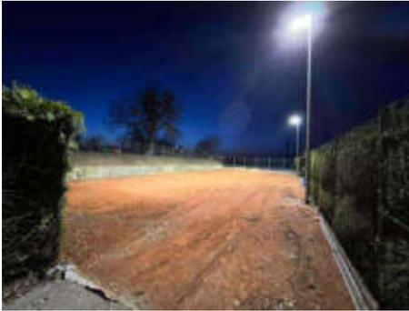
Danach ging es mit einer kleinen Verzögerung an die Arbeiten zum Austausch des Belages. Zunächst wurde der alte Sand höhengerecht abgezogen, aufgeladen und abtransportiert.
