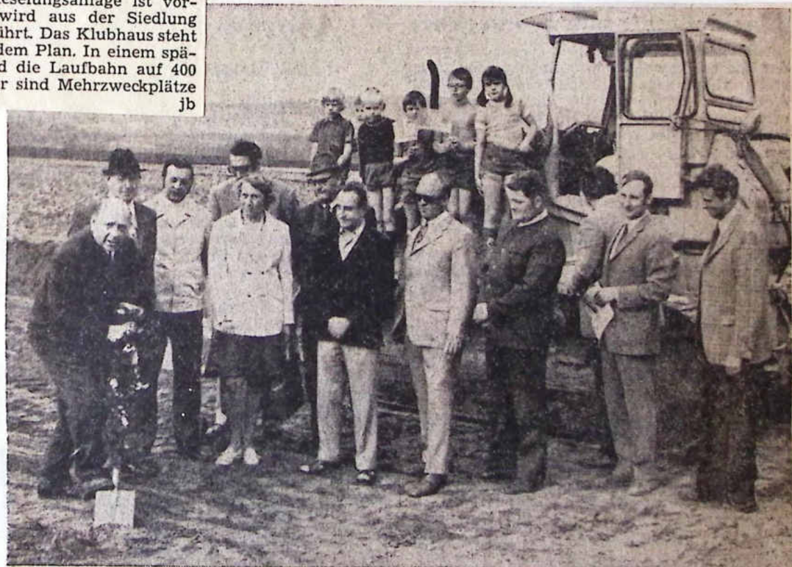
Mit einem festlich geschmückten Spaten tat Bürgermeister und Gemeindedirektor Friedel Siemen gestern die ersten Spatenstiche für den Sportplatz in Barienrode.
