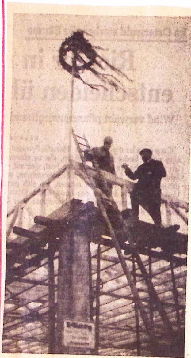
Vom Dachgerüst aus sprach Bürgermeister Siemen (rechts) anlässlich des Richtfestes der Gymnastikhalle in Barienrode zu den Vertretern des Landkreises, der Gemeinde, der Schule und der am Bau beteiligten Firmen. Neben ihm der Zimmerpolier, der, ebenso in luftiger Höhe, den Richtspruch sagte.
